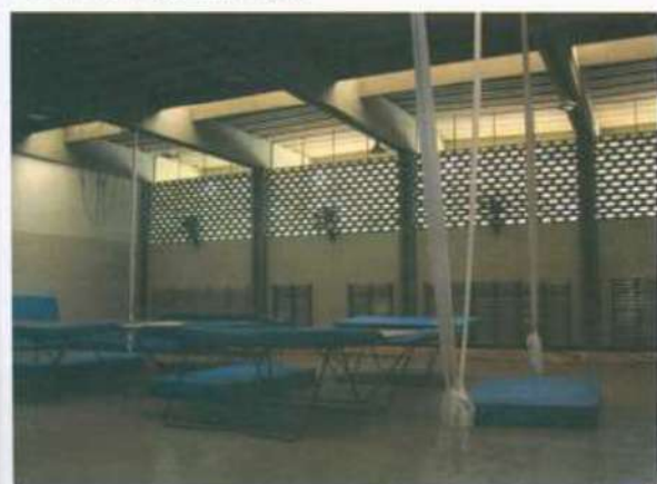
A boa estrutura ajudou a inclusão das instalações da UFV como locais de treinamento dos jogos olímpicos e paralímpicos
