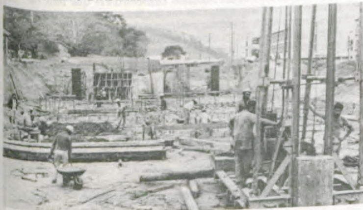
A foto mostra o aspecto geral da obra. Em primeiro plano, as últimas estacas sendo batidas, no segundo, o canteiro de obras e, no terceiro, a cortina de concreto.
