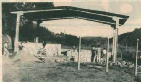
Aspecto do galpão que está sendo construído pelo Projeto Reciclar.
