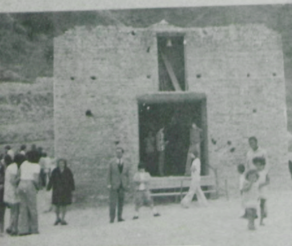
Capela do Senhor Bom Jesus (em construção)
