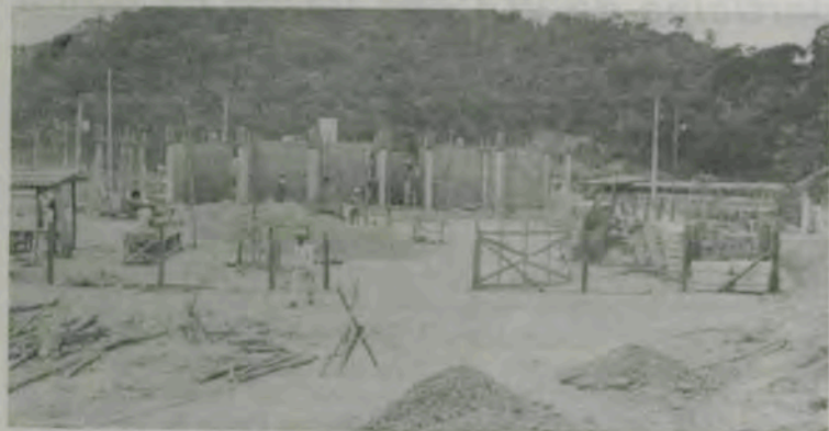
Aspecto das obras de construção do Laboratório de Engenharia Sanitária e Ambiental.
