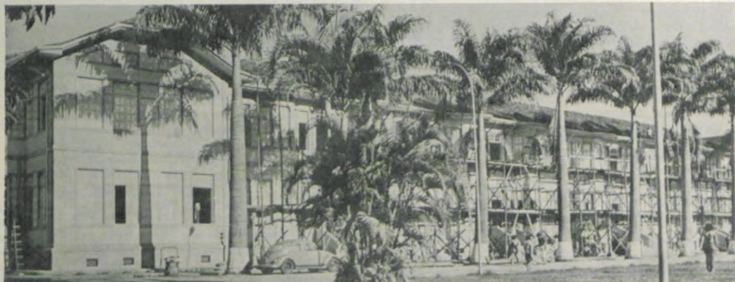
O alojamento antigo está sendo remodelado.
