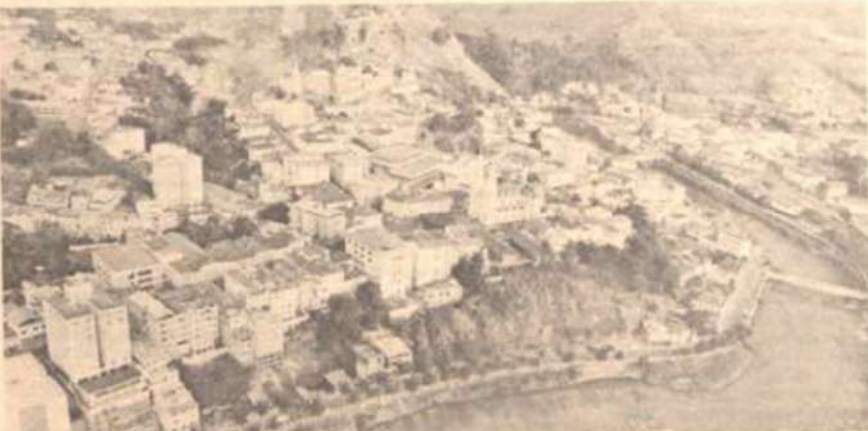
Vista parcial de Ponte Nova.
