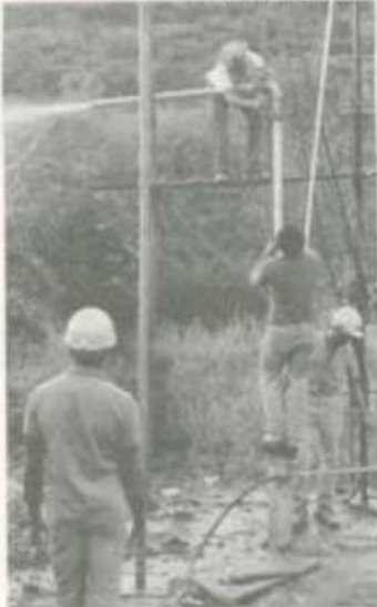
Os trabalhos de recuperação dos poços.
