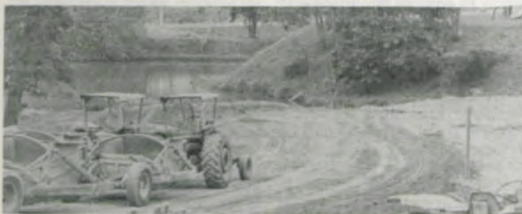
As obras em andamento.
