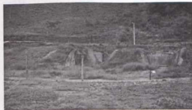
Silos-trincheiras localizados no estábulo novo da UFV
