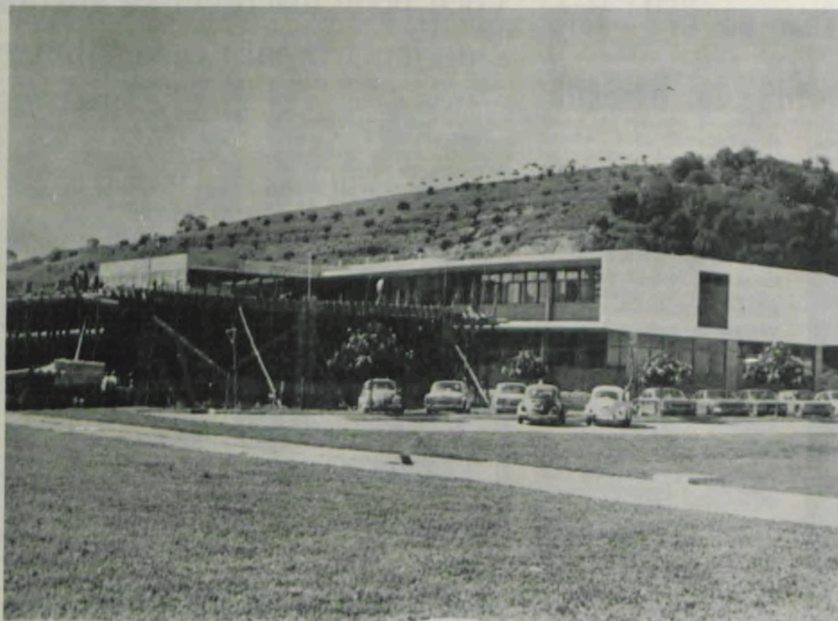
Está sendo construída a segunda ala do prédio da Fitotecnia.
