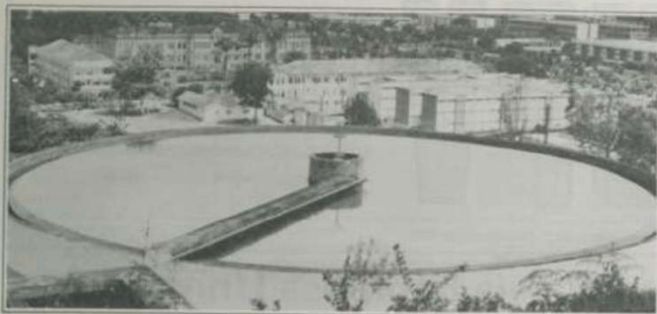
Vista do campus, tendo em primeiro plano o decantador da estação.
