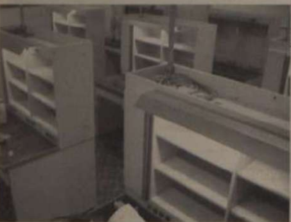
Instalações do novo laboratório de eletrônica em fase de montagem
