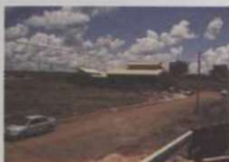
O início das obras do Condomínio
