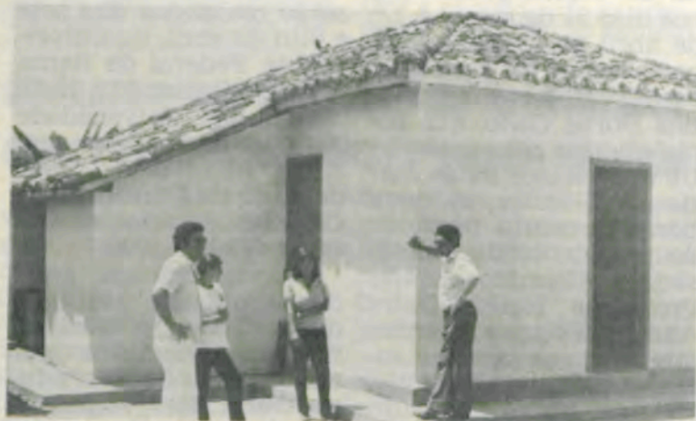
A escola de Santa Rosa já reformada.
