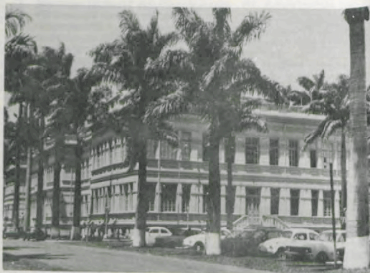
Edifício Arthur da Silva Bernardes, sede da Escola Superior de Agricultura da UFV.
