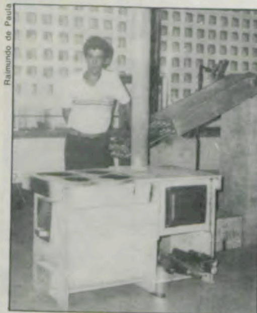
O fogão a lenha, construído de argamassa armada. São, ao todo, 16 peças.
