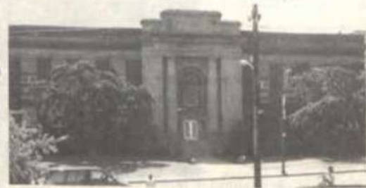
Um dos prédios da Universidade Técnica de Nova Scotia, em Halifax.
