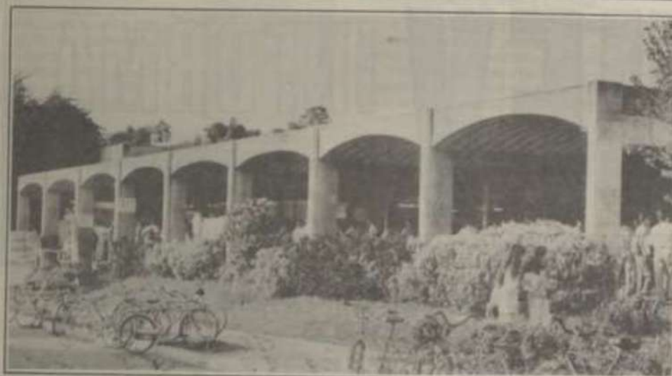
Fachada sudoeste do restaurante.
