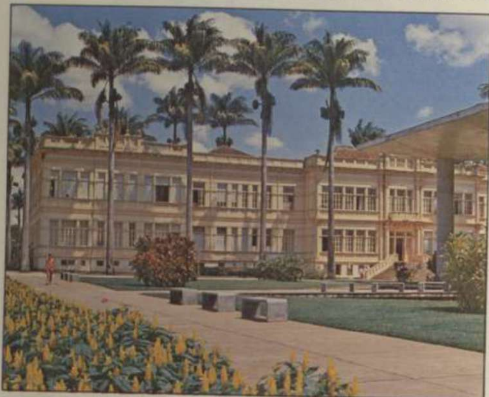
O Edifício Arthur da Silva Bernardes teve sua pedra fundamental lançada em 10 de junho de 1922, ficando a construção sob as ordens dos engenheiros Honório Hermelo Corêa da Costa, Mário Monteiro Machado e João Carlos Beilo Lisboa, sucessivamente.
