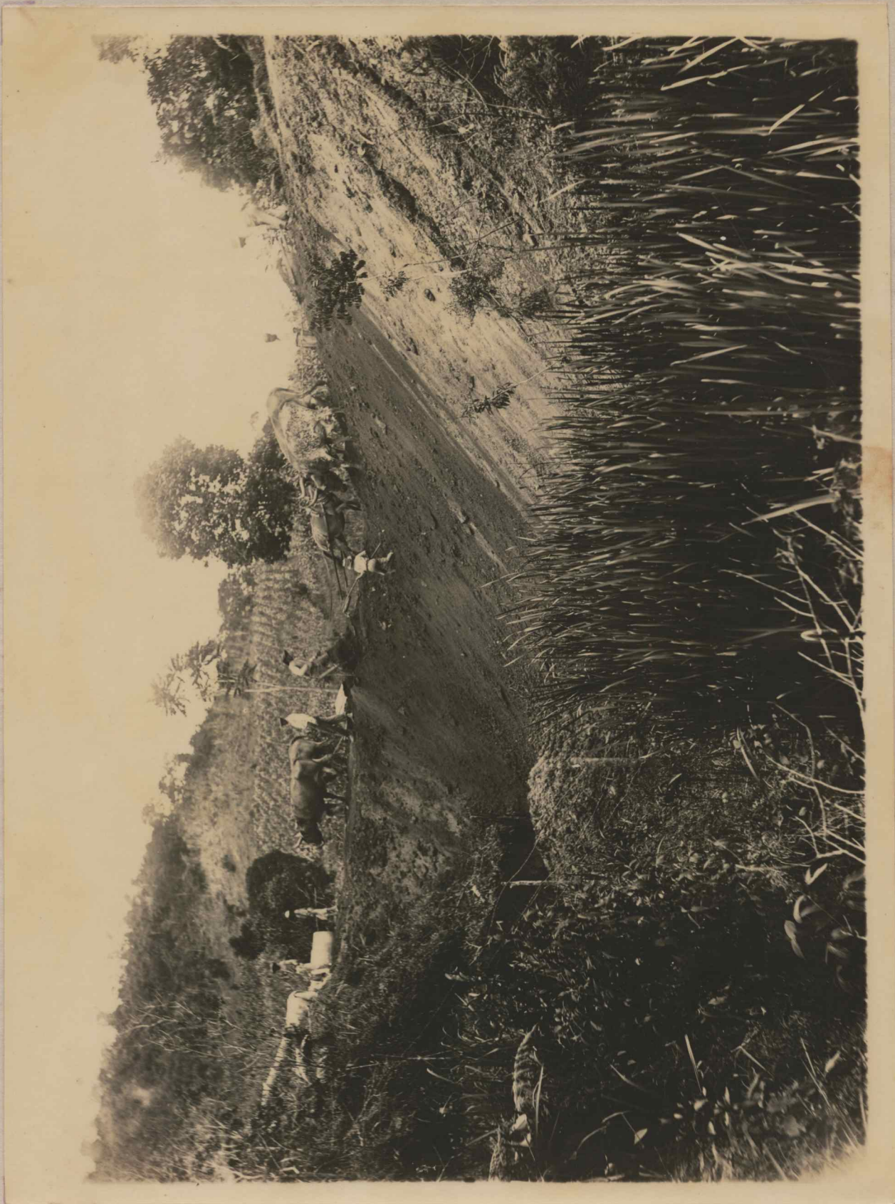
Construção economica de estrada de rodagens-Silvestre-Teixeiras
