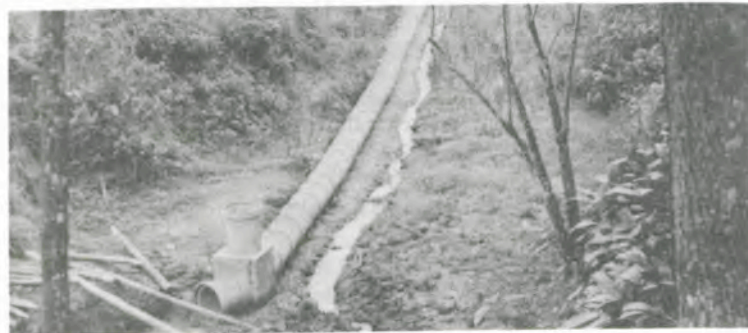
Vista parcial da canalização.
