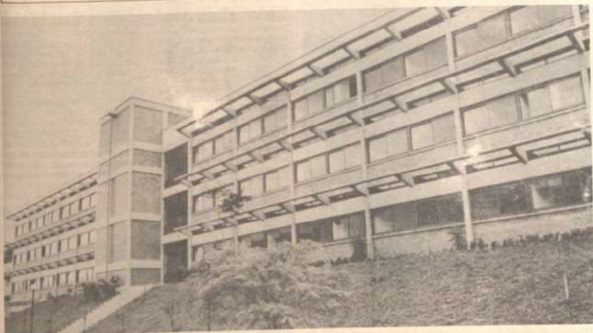
Vista geral do prédio do CCH.
