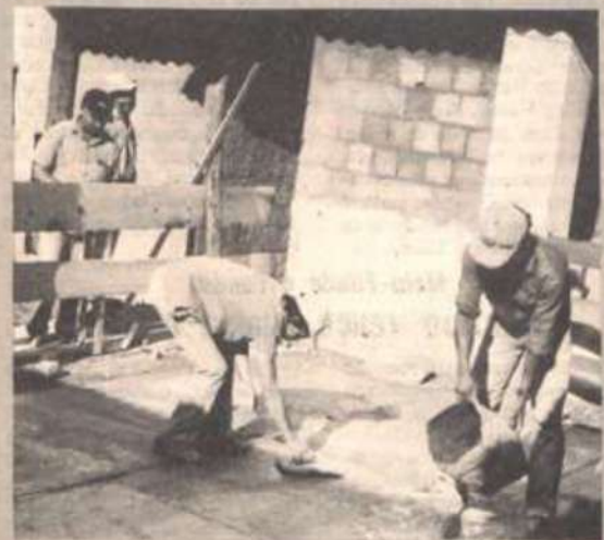
As obras estarão concluídas em breve.
