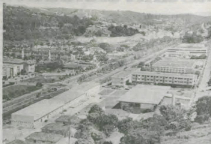
Ruas ajardinadas e prédios funcionais, antigos e modernos, compõem o «campus» da Universidade Federal de Viçosa.
