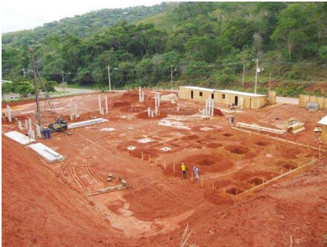
Os três campi da UFV tornaram-se canteiros de obras que projetam o futuro da Universidade e vão gerar mais de 1.300 empregos em Viçosa, Florestal e Rio Paranaíba. O prédio que vai abrigar os cursos de Medicina e Enfermagem já está com obras adiantadas
