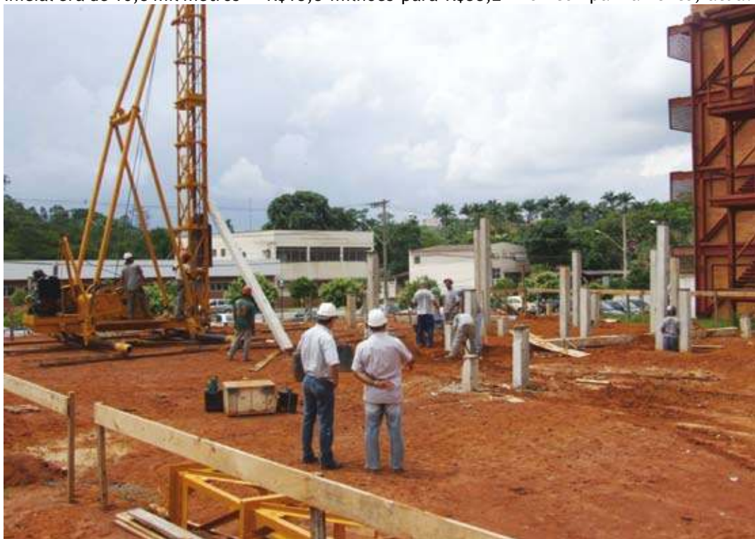
Ao lado do Supermercado Escola está sendo construído o prédio para abrigar os laboratórios das engenharias
