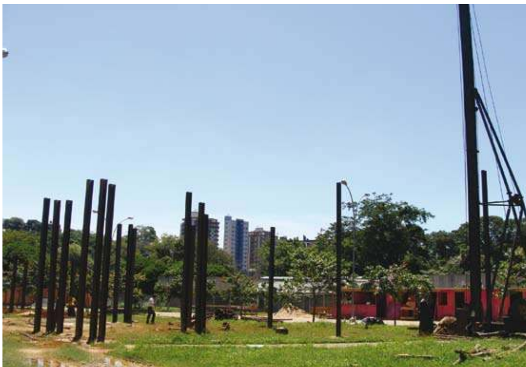
Área onde está sendo construído o Pavilhão de Aulas III, na UFV.
