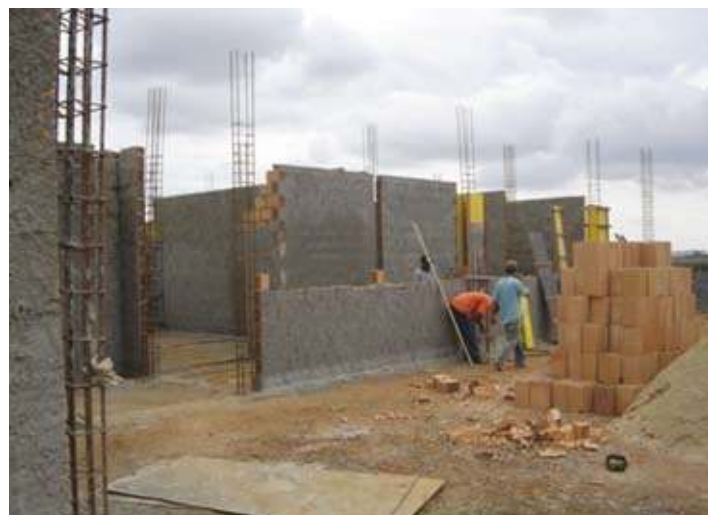
Obras da Biblioteca, no campus de Rio Paranaíba
