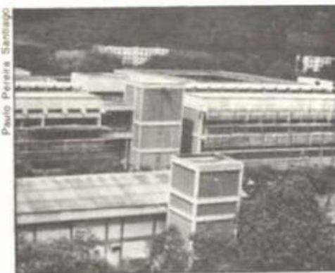
Obras do prédio da Biotecnologia.
