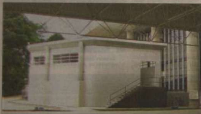
Anexo ao palco, foi construído um espaço, com 360 m 2 , para a preparação de espetáculos e outros eventos. São três camarins coletivos e dois individuais, todos com banheiros, além de copa e coxia, com 82 m 2 . O projeto previu até mesmo local para entrada de caminhões que transportam cenários e outros equipamentos. Os camarins poderão atender também aos eventos do Espaço Multiuso.
