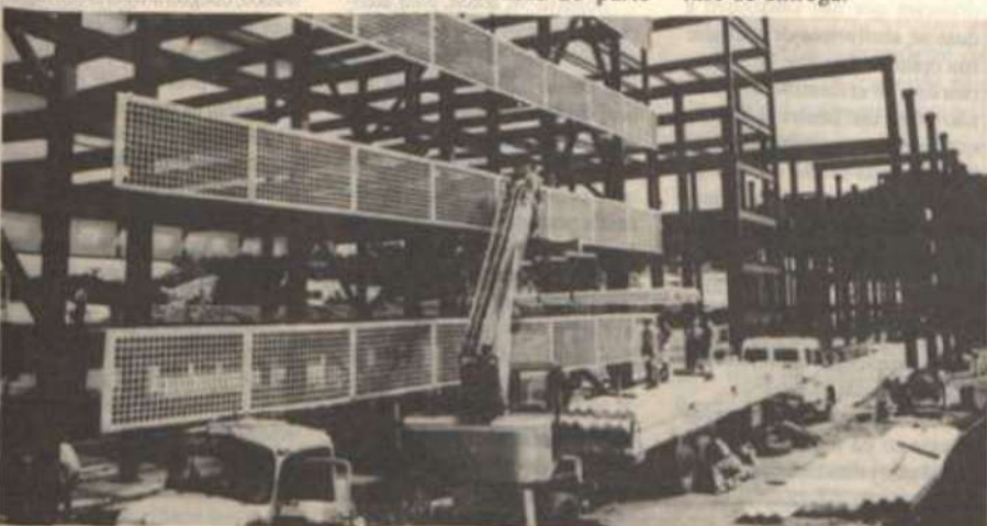
As novas instalações, em seu estágio atual.
