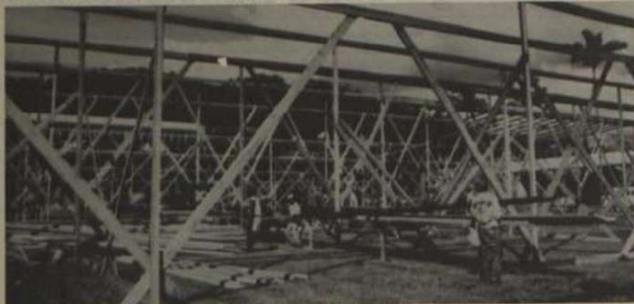
A Colação de Grau e o Baile de Gala serão realizados na estrutura que está sendo armada defronte o Edifício Reinaldo de Jesus Araújo.
