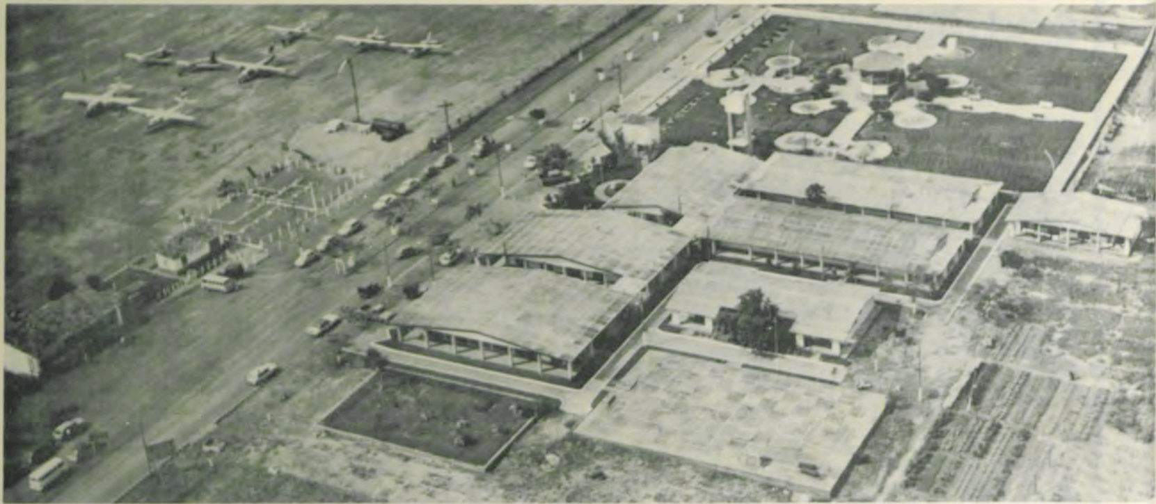
Vista aérea do «campus» avançado, em frente ao campo de pouso.
