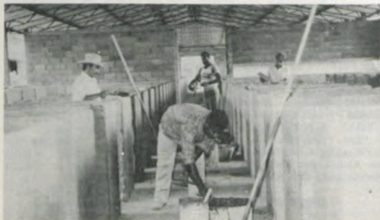
Aspecto do interior de um dos galpões.
