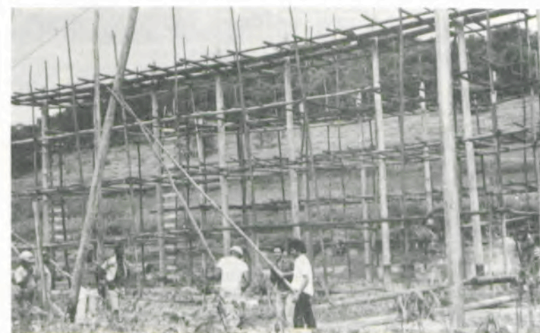
Obras de construção da microdestilataria de álcool.
