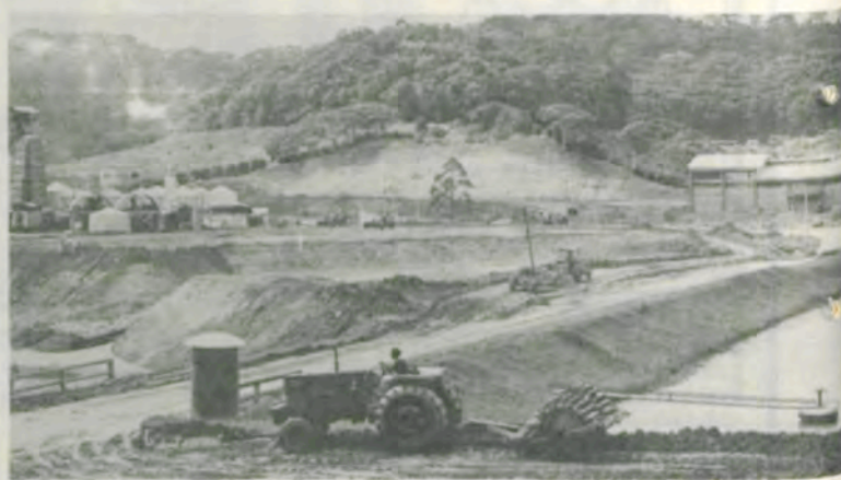
A patrulha mecanizada trabalhando em obras de terraplenagem, na área onde será construído o prédio do Departamento de Engenharia Agrícola.
