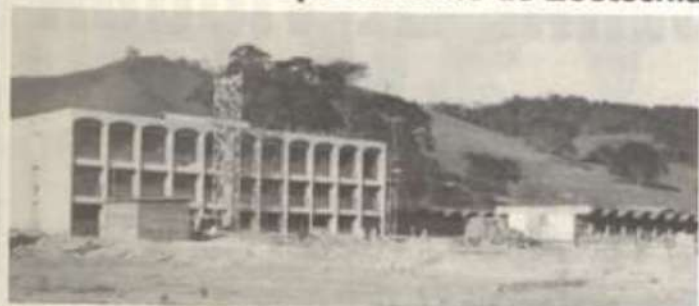
Vista do canteiro de obras.
