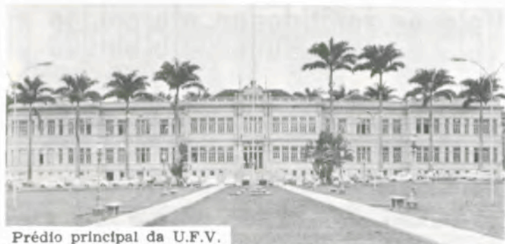
Prédio principal da U.F.V.
