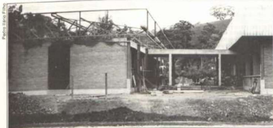
As obras da nova sede da PFC encontram-se em fase bastante adiantada.
