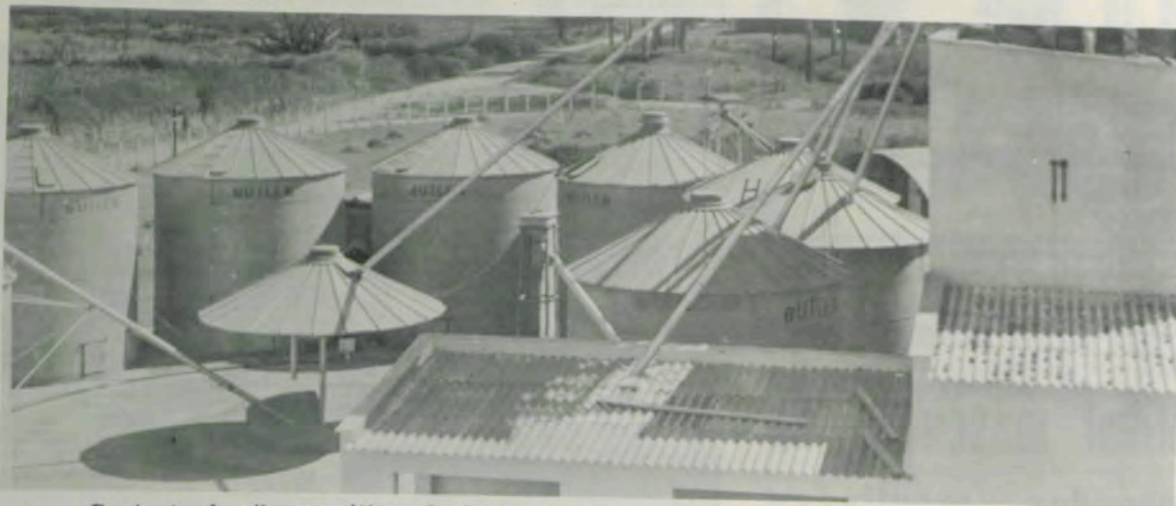
Conjunto de silos metálicos do Setor de Armazenamento e Processamento de Grãos.
