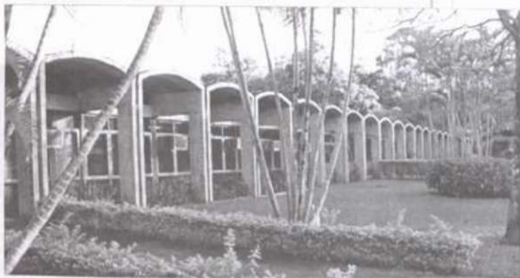
Fachada principal do prédio que abriga o Centreinar
