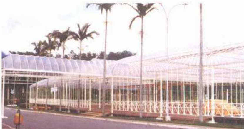
Estrutura metálica construída para as solenidades da formatura
