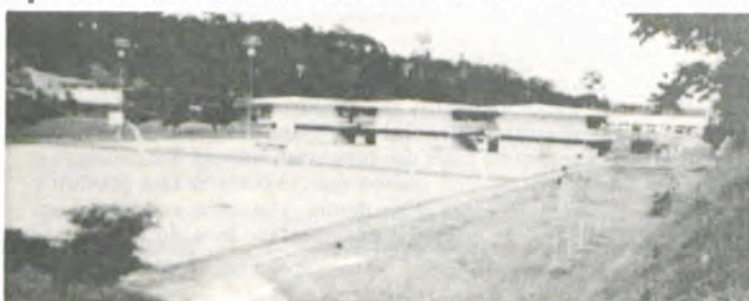
Vista parcial das instalações do Departamento de Educação Física.
