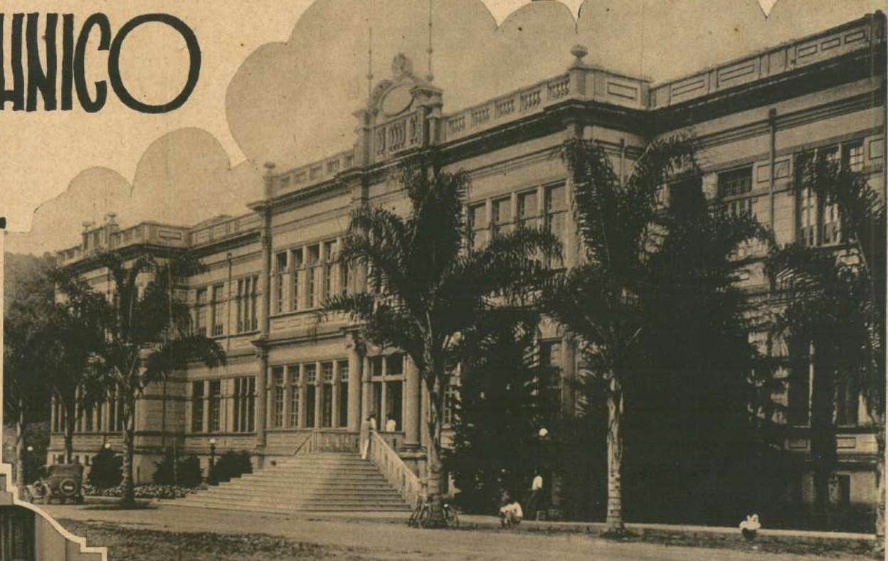
O edificio principal da Escola — Administração, aulas e laboratorios.
