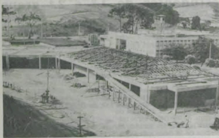
A armação para o telhado já em fase adiantada.
