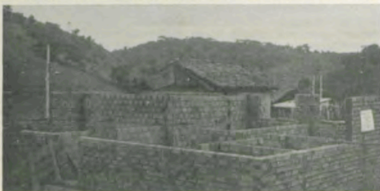
As obras do Posto de Saúde de Zito Soares.
