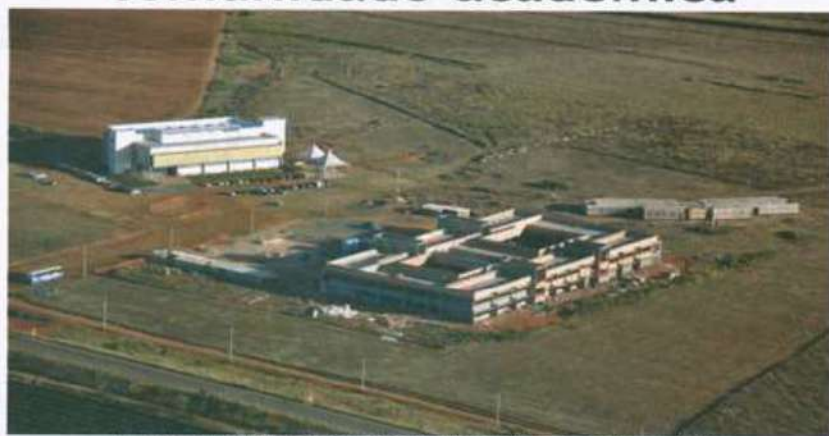
A expansão do CRP II inclui pavilhão de aulas e rede de abastecimento de água
