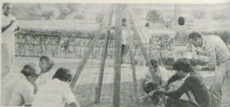
A foto mostra a construção de um silo.
