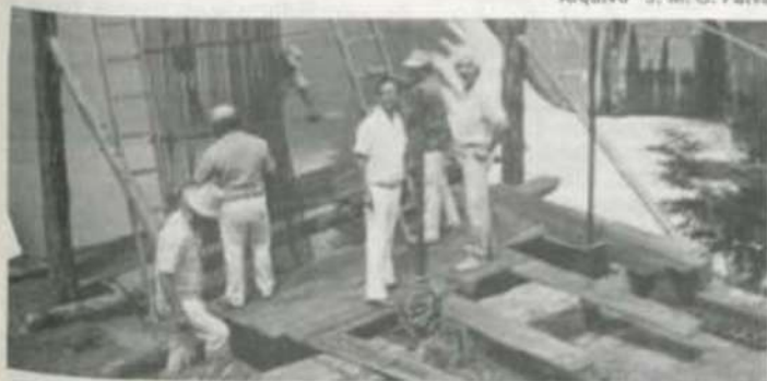
Aspecto das obras na Usina do Casquinha.
