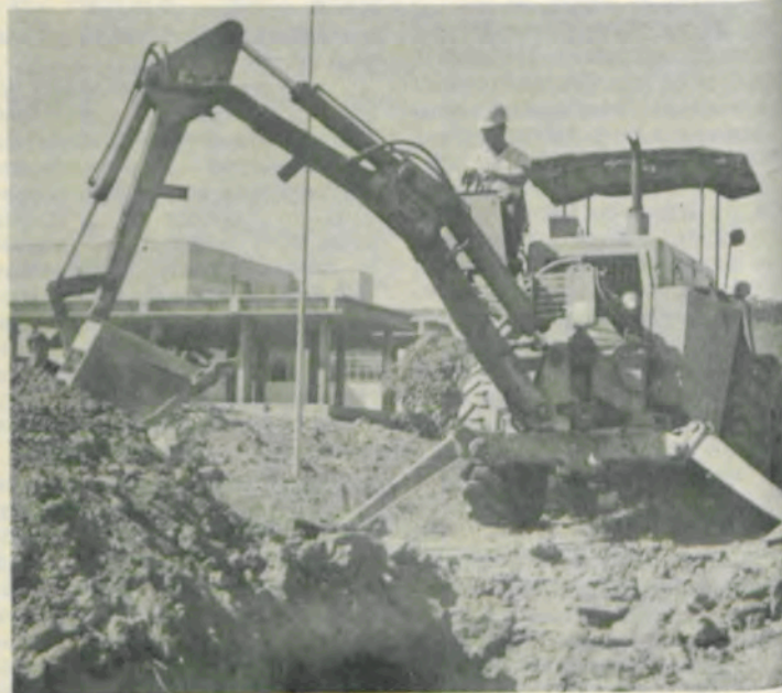
Um detalhe do trabalho do equipamento.
