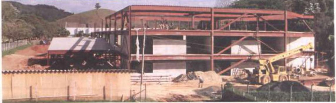
A estrutura metálica dos três pavimentos e parte da alvenaria já estão concluídas.
