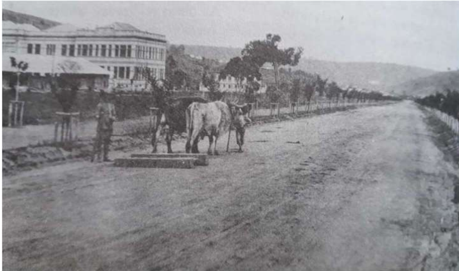
Obra de preparação da Reta. A pista acertada usando-se dormentes arrastados com bois, vendo-se as magnólias recém-plantadas.
