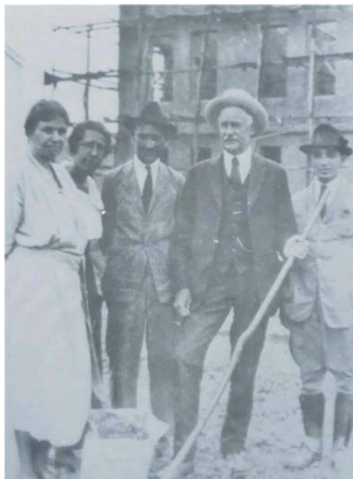
P. H. Rolfs (segurando a enxada) tendo à sua direita o Eng. Bello Lisboa, durante a construção do prédio principal da ESAV (Ed. Arthur Bernardes).
