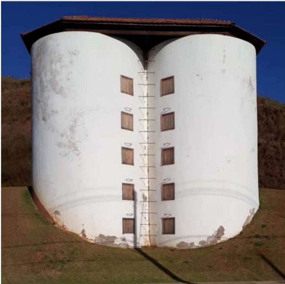
Primeiros silos construídos no Departamento de Zootecnia.
