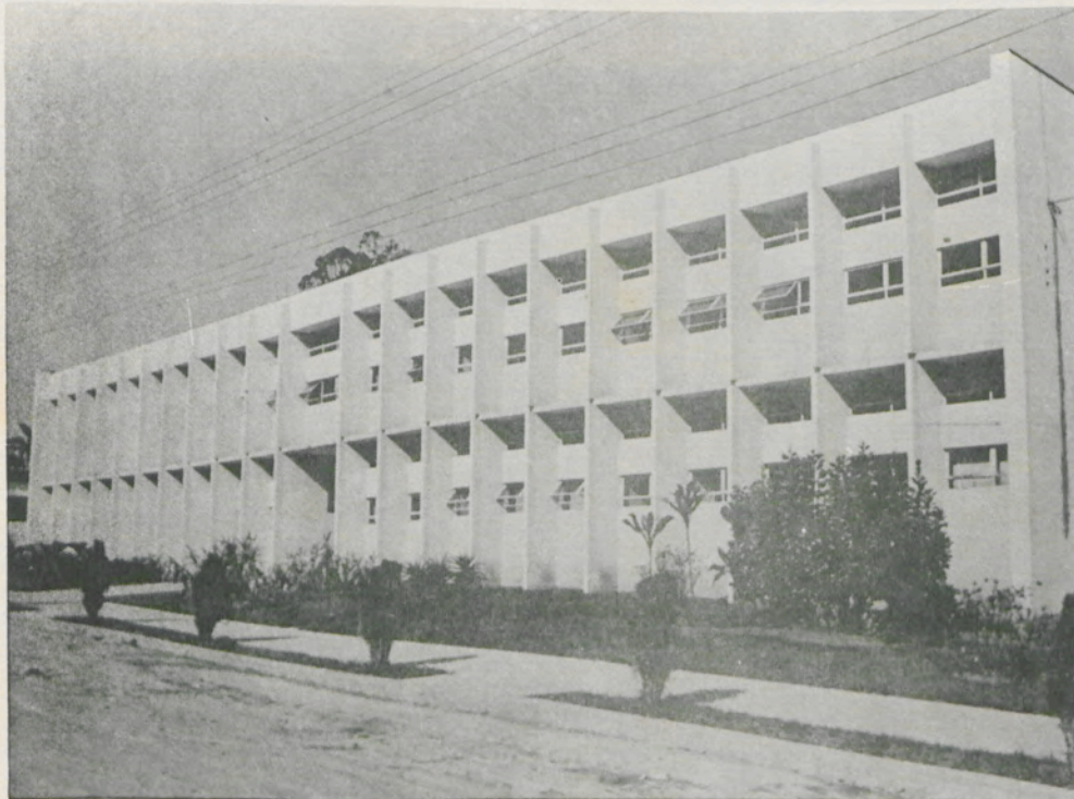
Prédio de Tecnologia produtos vegetais
