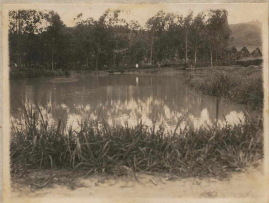
Vista parcial do novo lago construido
