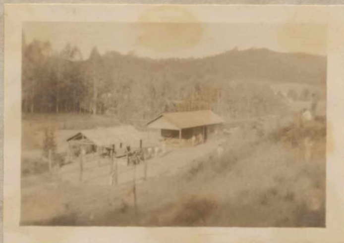
Sede de campo do Departamento Vista parcial - Trabalhos de reforma
