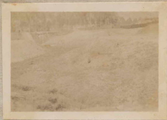
Buraco onde foi construido o lago.
