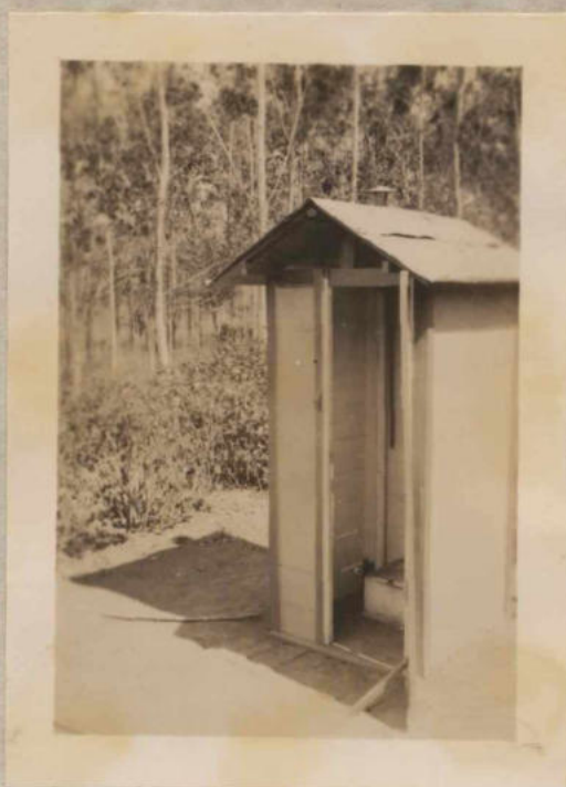
Fossa seca higiénica para uso dos operarios.
