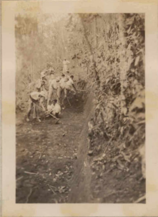
Turma A do M.4 - Aula pratica de construção de uma estrada florestal.
