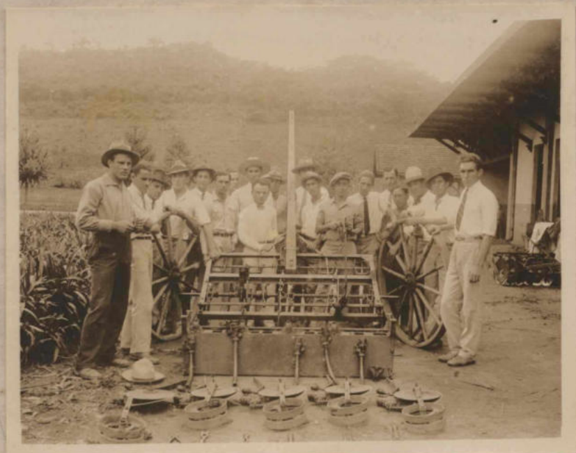
Aula pratica. Desmontando, estudando e montando uma plantadeira de 5 fileiras para cereais.
